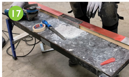
Zum Trennen des Duschprofils muss das Duschprofil eine gute Auflage haben, z. B. mit zwei Dachlatten, die als Unterbauung des Profils dienen. Die Dachlatten reichen nur bis zum Rahmen des Duschprofils. Die Schutzfolie wird nur im Schnittbereich entfernt und bleibt bis zur endgültigen Fertigstellung des Bades auf dem Profil.
