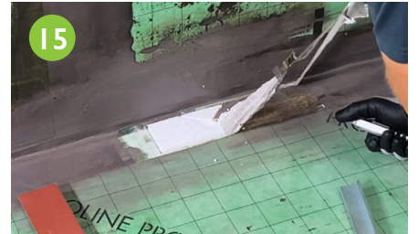
Entfernung des Schmutzschutzes aus dem Rinnenkörper.
