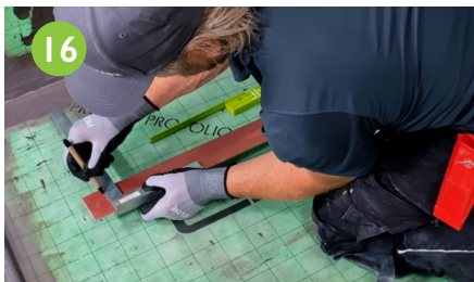
Trennlinien mittels einem Anschlagwinkel auf das Duschprofil übertragen.
