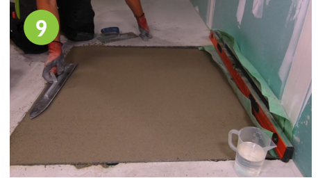
Glätten Sie die Estrichfläche mit der Glättkelle.
