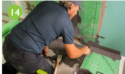
Übergänge zwischen Wand und Boden werden mittels geeigneter Dichtschlämme und PROFOLIO Dichtband abgedichtet. Gefällekanten im Eckbereich werden mit den PROFOLIO Ausgleichsecken abgedichtet.
