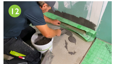
Auch im Bodenbereich die Dichtschlämme mittels Zahnkelle 4 mm und Traufel unter der Dichtmanschette auftragen und blasen- und hohlraumfrei die Dichtmanschette in die Dichtschlämme eindrücken.
