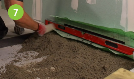
Einbringen des Gefälleestriches in die dafür vorgesehene Montagestelle.
