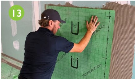
Abdichten der Wandflächen mit der PROFOLIO Abdicht- und Entkopplungsbahn.
