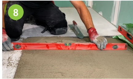
Abziehen des Gefälleestriches mit der Wasserwaage. Achten sie auch die 1,5 - 2 % Gefälle zum Rinnenkörper.
